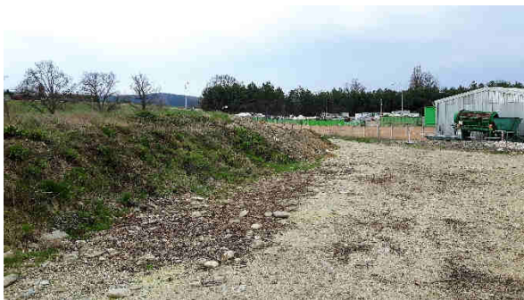
Zhutněná plocha a svah v místě, kde bude nutné doplnění ornice a modelace paty svahu
