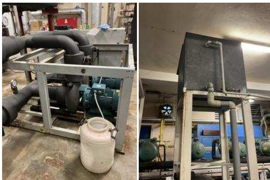
Obrázek 3 - chladicí technologie a nádrž s chladivem pekasol
