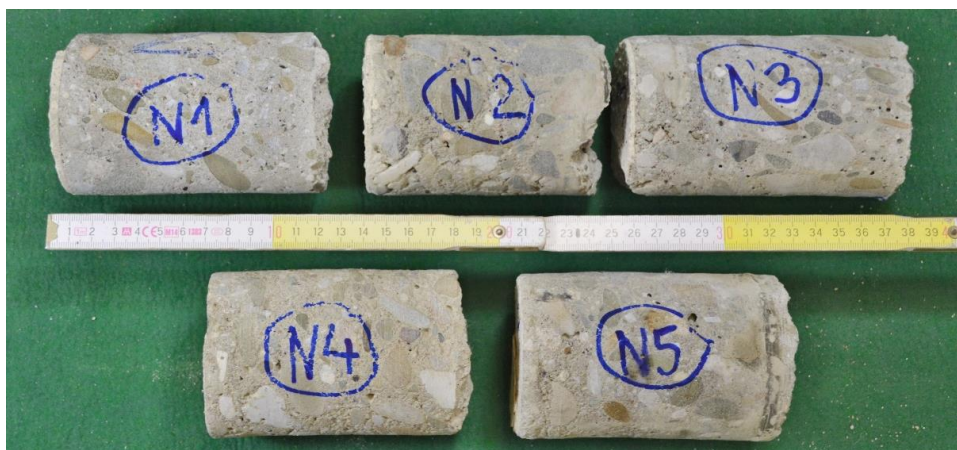
Obr. 1: Zkušební vzorky N 1 až N 5 odebrané ze stěny krytu CO v 1. PP.
